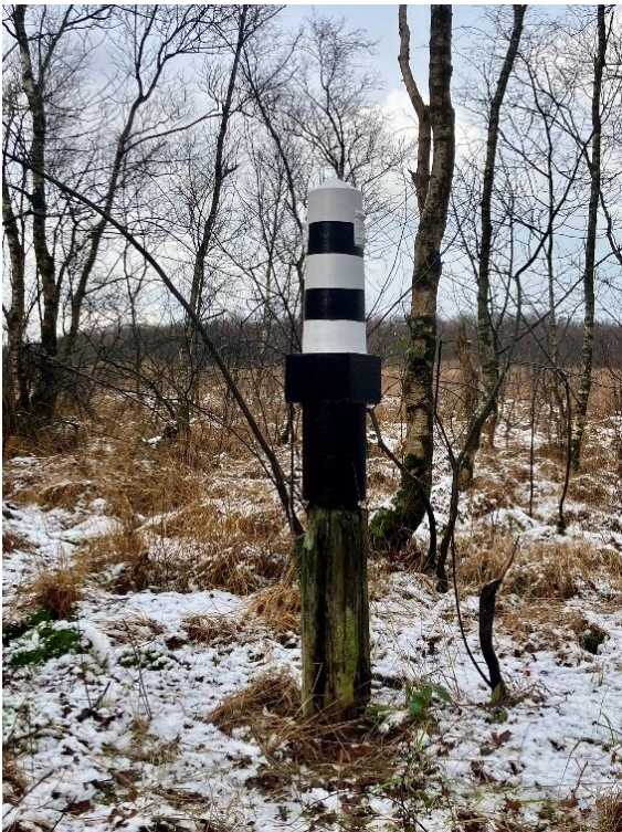
De foto toont goed de verzakking die in het veengebied heeft plaatsgevonden.
